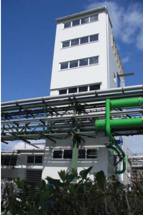
500-Tonnen-Pilotanlage am Standort Gendorf, Oberbayern Finanzierung:
